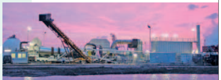
Thermische grondreiniging en on-sitesanering
